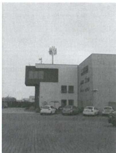
Widok obiektu wraz z zainstalowanym zespołem antenowym
