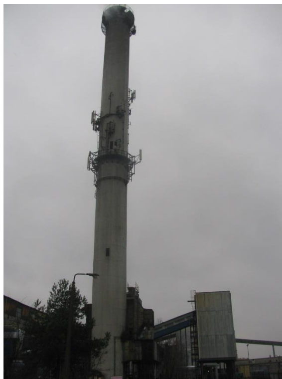
Zał. nr 1: Widok ogólny instalacji radiokomunikacyjnej.
