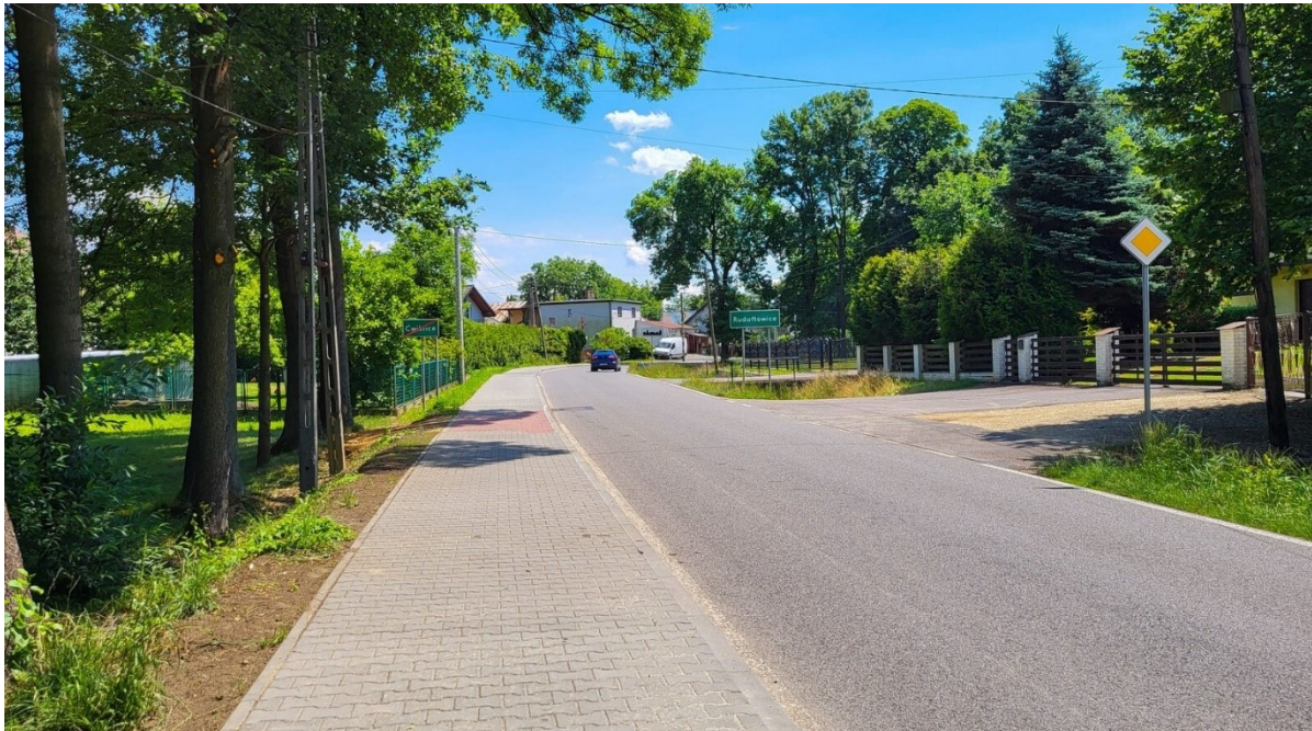
Zdjęcie 7. Nowo wybudowany chodnik przy ul. Zawadzkiego z Ćwiklic do Rudołtovic
