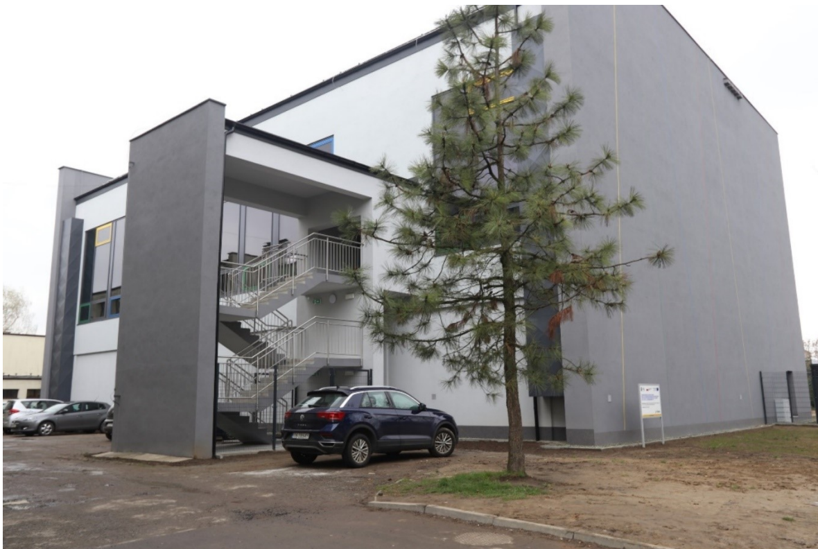
Zdjęcie 4. Budynek basenu po termomodernizacji
