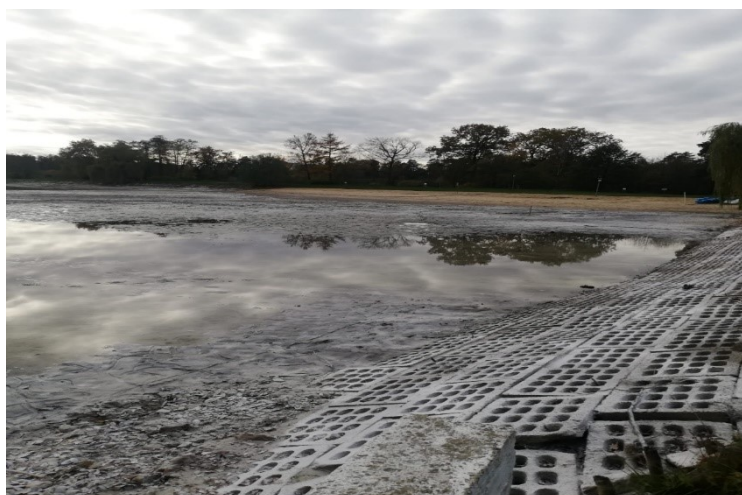
Zdjęcie 18. Rewitalizacja dolnego stawu Suszec wykonana w 2023 r.
