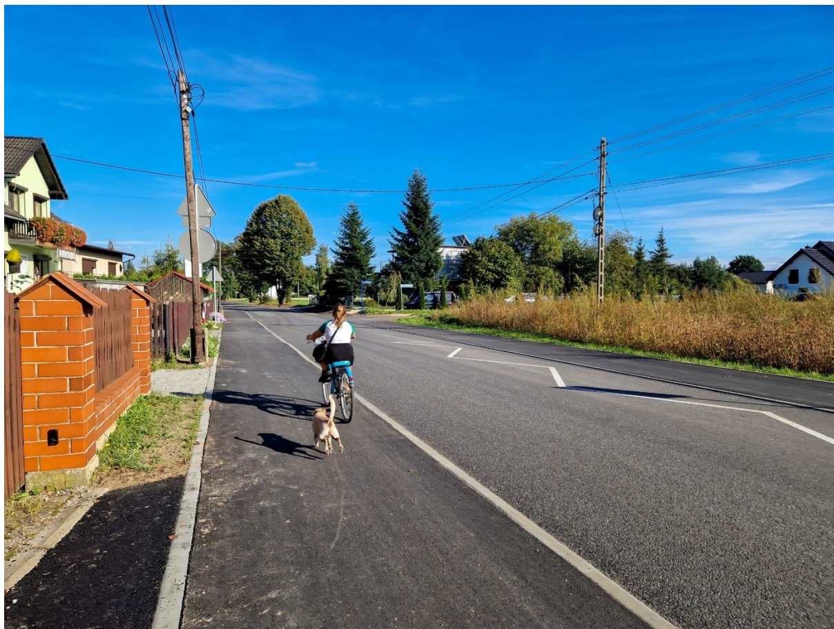
Zdjęcie 6. Przebudowana ul. Miodowa we Frydku
