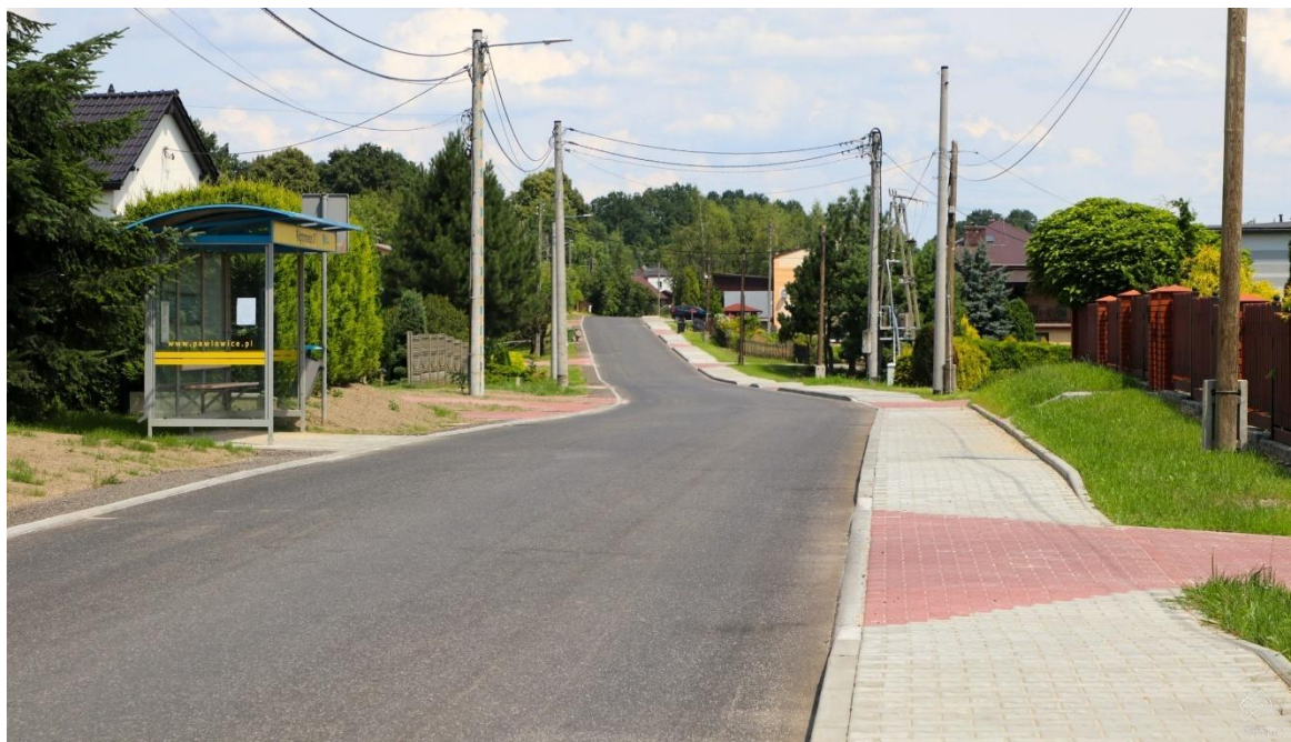
Zdjęcie 9. Przebudowana ul. Zebrzydowska w Pielgrzymowicach
