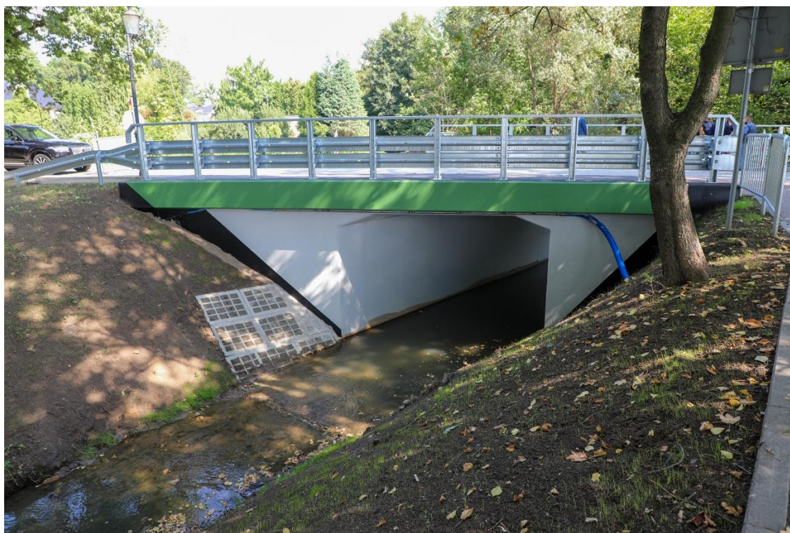
Zdjęcie 13. Przebudowa przepustu w ciągu ul. Uzdrowskiej w Goczałkowicach.
