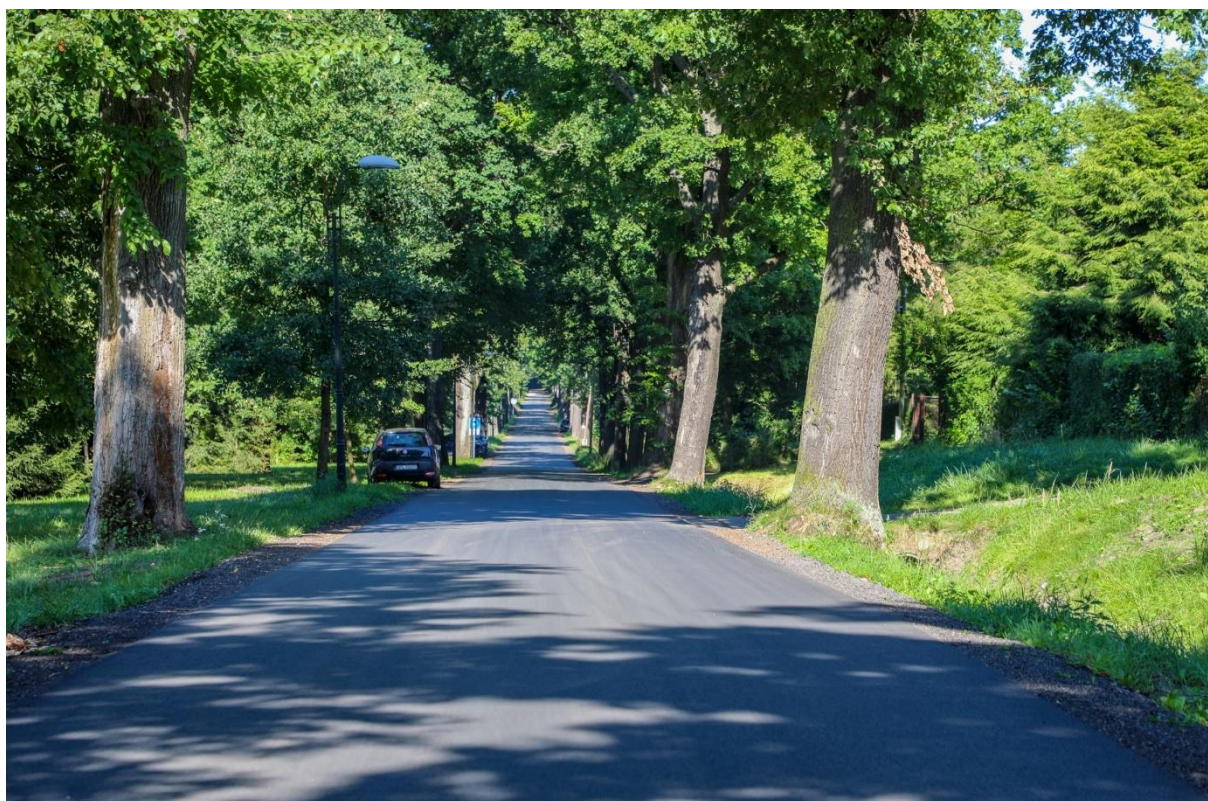
Zdjęcie 14. Remont ul. Leśników w Kobiórze.
